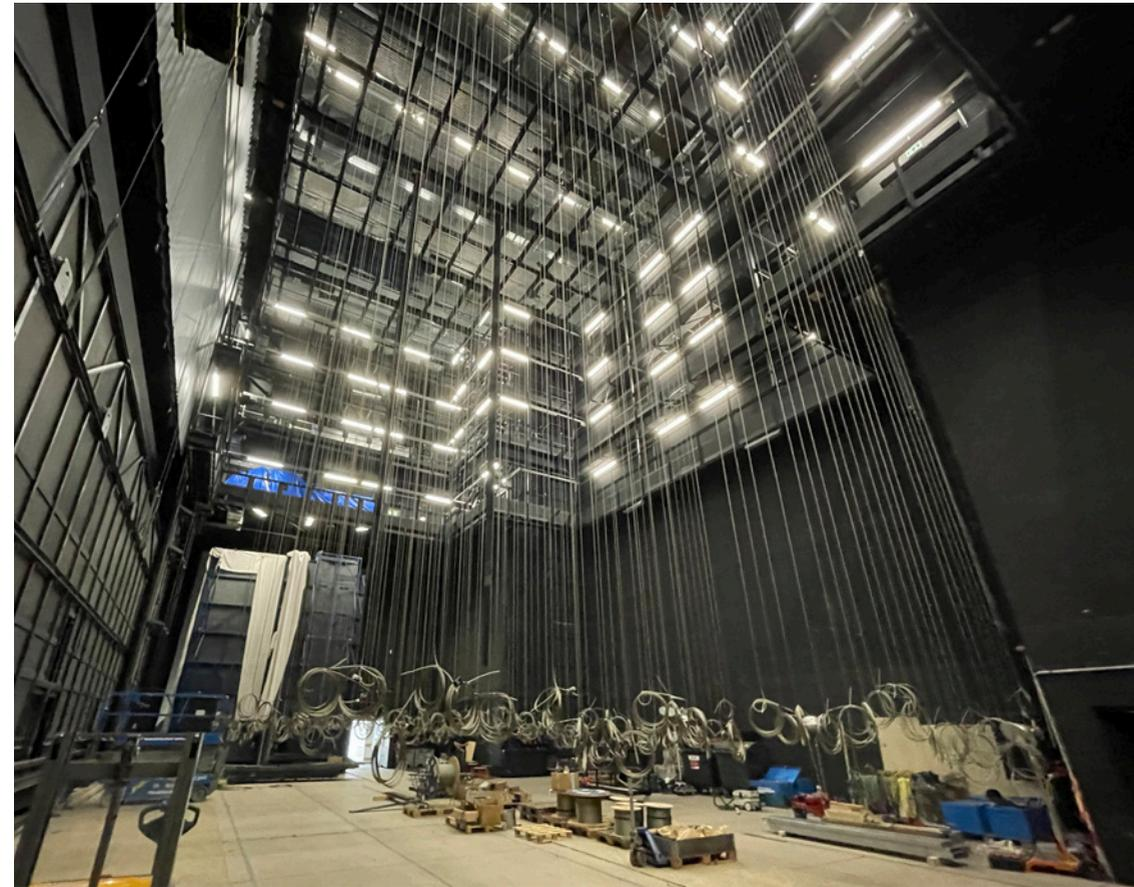
Das Projekt umfasste neben der Demontage des kompletten Altbestandes die Montage der neuen Antriebe wie Prospektzugwinden, Schwerlast-, Panorama-, Nullgassen-, Hinterbühnen- und Punktzügen sowie eines Schleier- und eines Portalblendenzugs. Zudem wurde die komplette elektronische Steuerung inkl. aller Steuerpulte auf den aktuellen Stand der Technik gebracht und dem sicherheitstechnischen Standard moderner Bühnensteuerungen angepasst.
